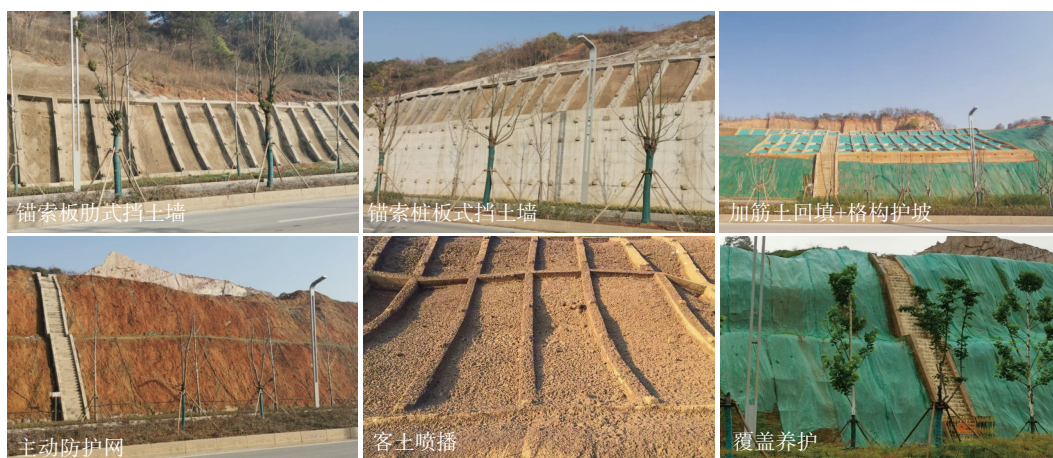
图 4 森林大道边坡主要支挡与复绿设计
