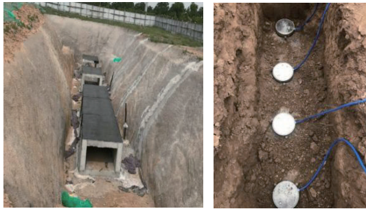
图4 西安某管廊测试现场 Fig. 4 Utility tunnel test site at Xi'an
