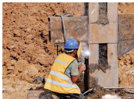
图 10 牛腿及加劲板焊接
