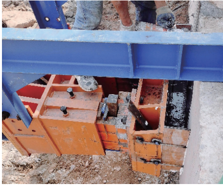
图 14 二次灌浆 Fig. 14 Secondary grouting
