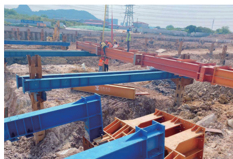
图 12 钢桁架安装
