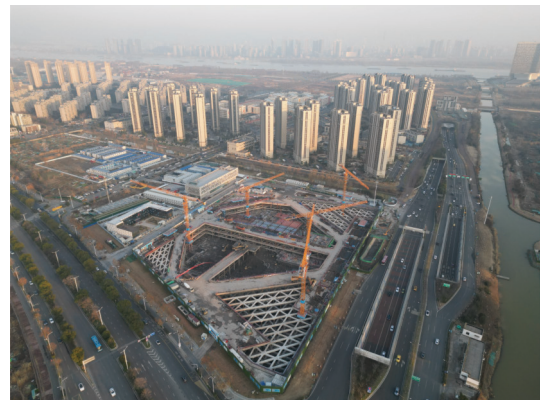
图 14 基坑开挖到底实景图
