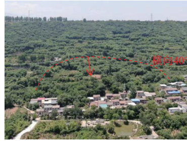
图1 东张坡村滑坡全貌(镜像210°)
