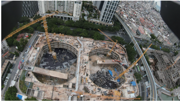
图9 基坑开挖完成
