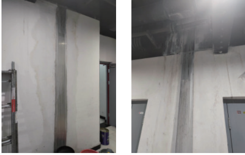
(a) 车站机电层渗漏照片
