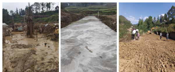
(1) 钻孔施工 (2) 混凝土板浇筑 (3) 桩顶覆土
