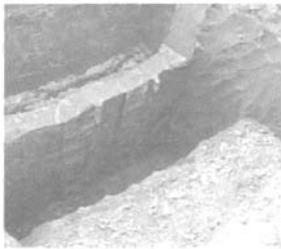
图 4 开挖出的振动切槽防渗墙墙体
