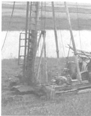
图7 缩径地层振动刮刀切槽施工图
