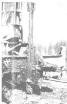
图1 振动切槽施工图
