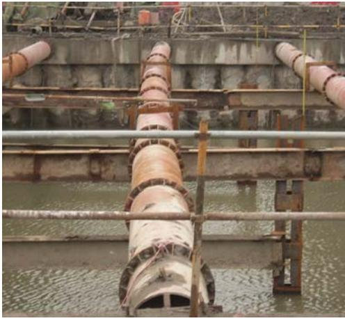
图3 典型扭曲钢管支撑
