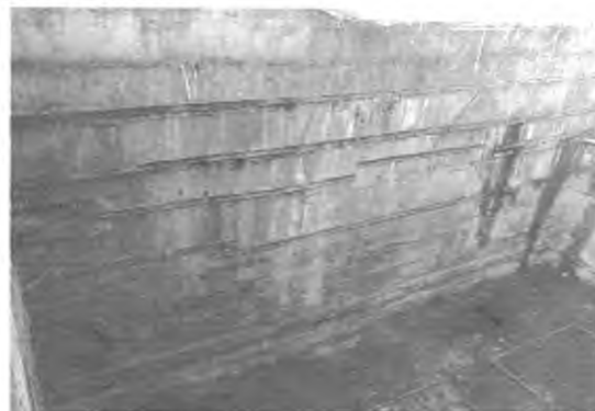
图3 基坑支护坡面状况
