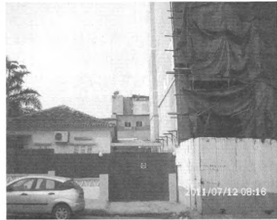
图 5 封顶后的建筑现状
