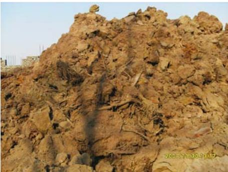
图3 形成橡皮土后换填挖出的由树根、杂草形成的储水构造物
