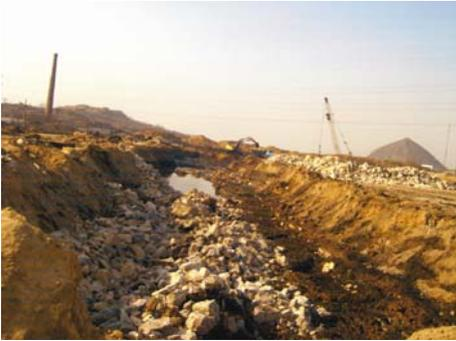
图2 用碎石先换填软弱土再进行强夯
