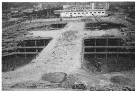
图 3 栈桥支撑体系现场照片
