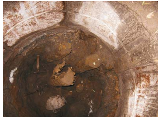
图4 桩孔内遇木桩、柱状条石
