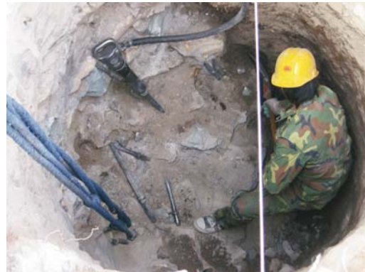
图3 桩孔内遇已有护岸浆砌石
