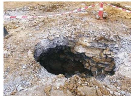
图2 航站区揭露的溶洞
