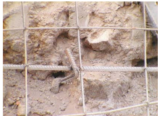
图8 不宜采用的“J”型连接方式
