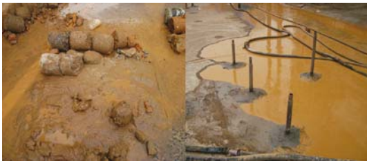
图4 钻探岩芯及注浆加固照片
