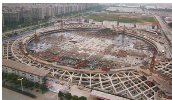
图 3 圆环内支撑实景图
