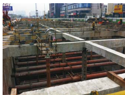
图2 河西某地铁车站基坑
