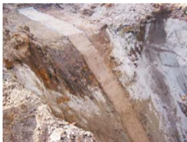
图2 成型后的等厚式EC隔渗墙
