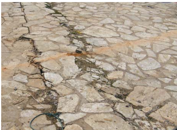
图4 砼地面裂缝
