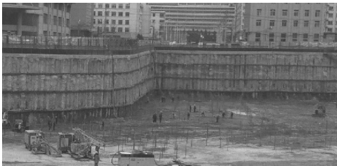
图3 咬合桩施工成果图
