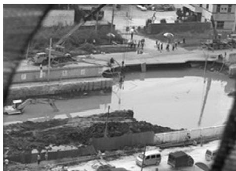
图4 某基坑水管爆裂后发生坍塌
