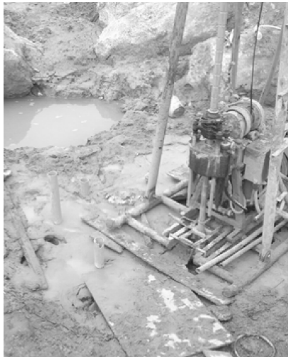
图 3 新型帷幕复合注浆法帷幕施工图
