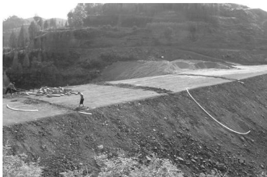
图4 基床底部三个断面沉降管布置图片
