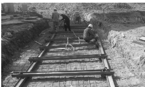
图 2 门架工字钢施工图
