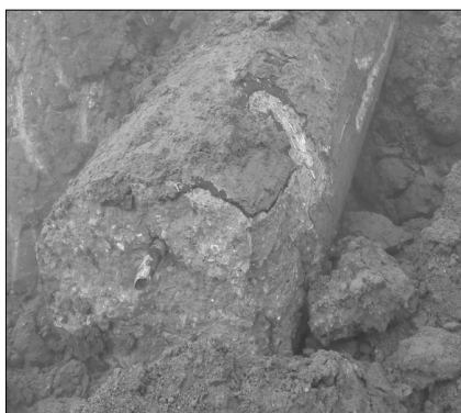
图2 深层水泥浆包裹桩身图
