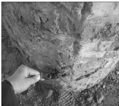
图3 浅层水泥浆包裹桩身图
