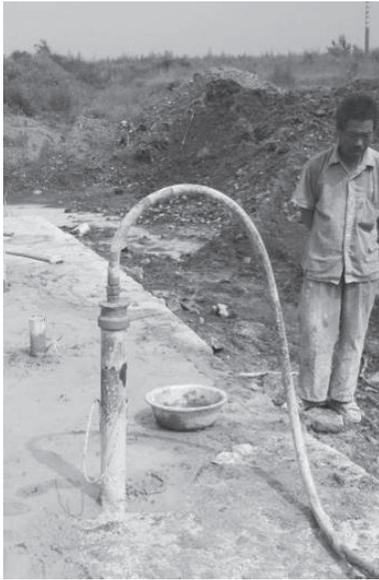
图4 压力注浆施工照片
