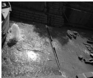
图 1 船坞漏水现场
