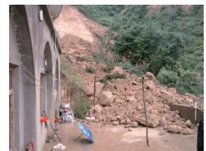
图 8 吉县李家沟切坡建房引发黄土崩塌
