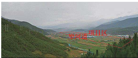
图1 机场场区全貌图
