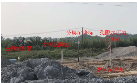
图 2 模型箱效果及现场实物图
