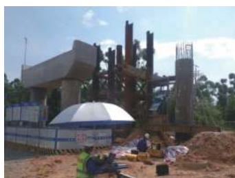
图 2 桩柱一体施工水平荷载试验现场
