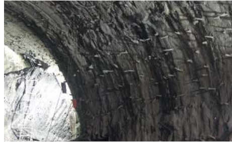
图8 围岩-支护叠合结构体系
