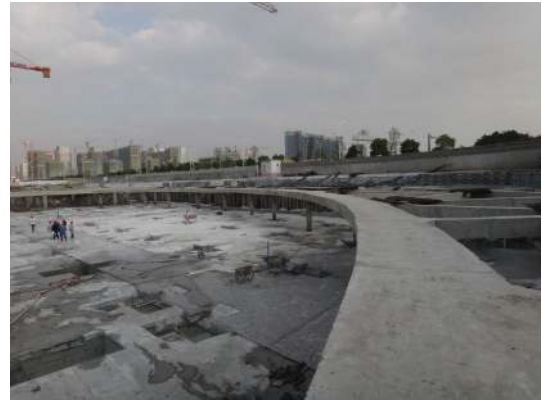
图7 基坑开挖现场图
