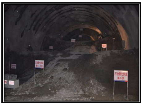
图12 自进式锚杆开挖实施效果图
