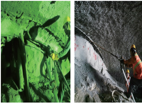
图 10 自进式锚杆打设试验现场图
