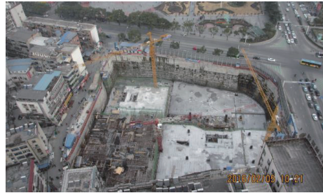
图9 逆作法墩式挡墙整体支护效果图
