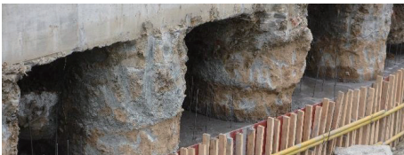
图7 墩间土体置换
