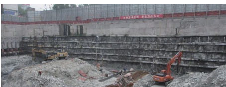
图8 基岩拉锚施工
