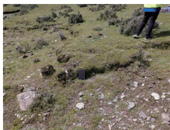
图 2 弃渣场边坡局部出露板岩
