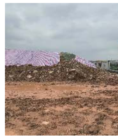
图6 基坑顶堆土照片 (镜向N, 基坑位于照片右侧)
