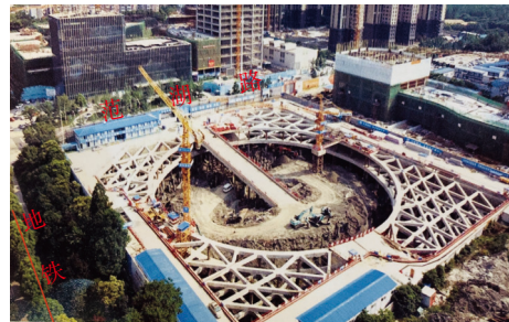
图 2 基坑支护全景实拍图
