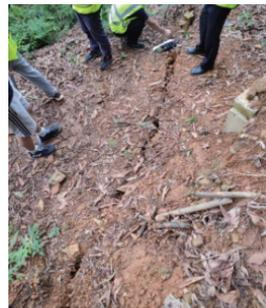
图2 滑坡后缘裂缝L2
