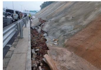
图4 边沟处滑坡前缘剪出口
