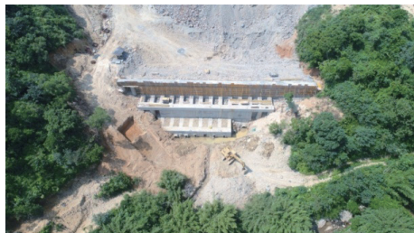
图 13 三排桩刚架支挡结构
