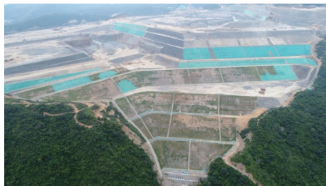
图 12 主回填区边坡竣工后航拍照片
