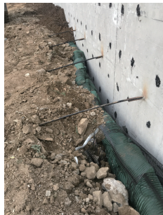
图 9 贴近挡墙一侧加筋土
