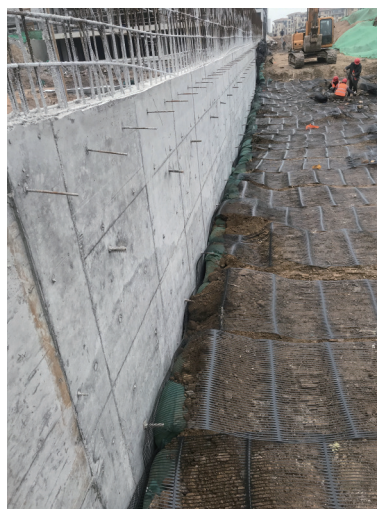
图 5 铺设单向土工格栅
