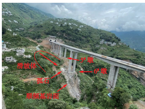
图1 路堑滑坡地貌图(处治后)
