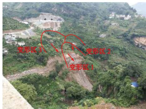
图2 滑坡堆积体地貌图(处治前)
