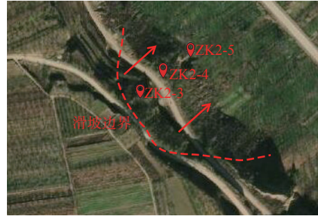
图 4 滑坡现场全貌图
