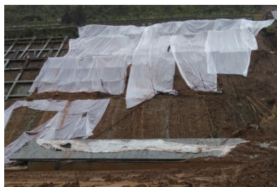
图 5 现场临时措施现状
