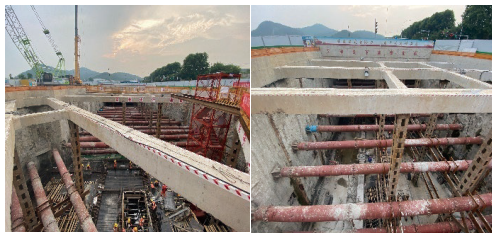
图 3 基坑开挖现状
