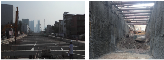
(a) 钢筋混凝土支撑现场图
