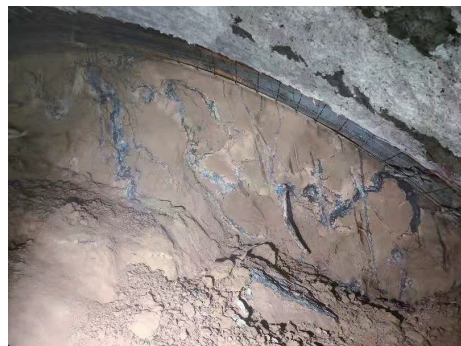
图 8 现场帷幕注浆加固效果
