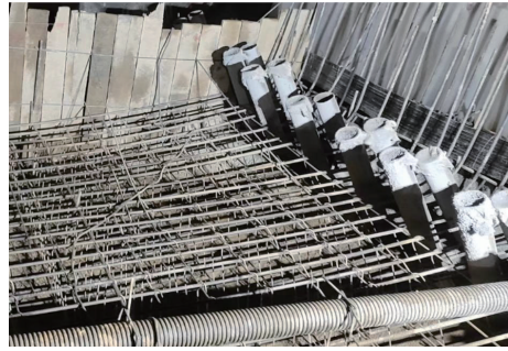
图 7 现场锁脚钢管桩加固
