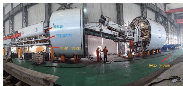
(d) 同步注浆管路接入盾构系统
